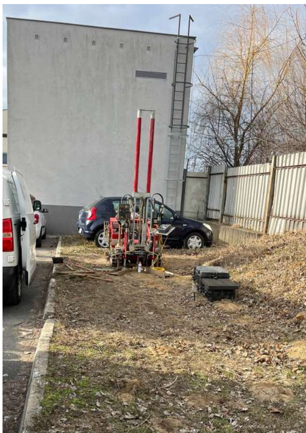
Foto 9: Realizace statické penetrační zkoušky CPTu 2a.
