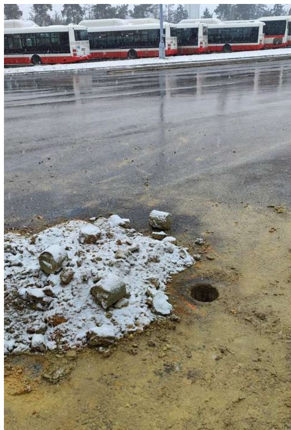
Foto 3: Realizace jádrového vrtu JV1.
